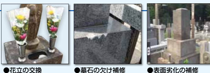
●花立の交換 ●墓石の欠け補修 ●表面劣化の補修
